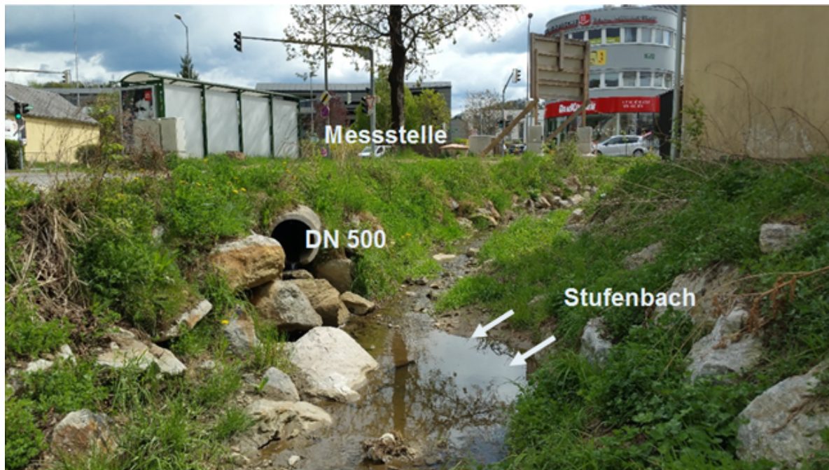
Abbildung 50: Einleitungsstelle des Niederschlagswasserkanals aus der Ziegelstraße in den Stufenbach © TU Graz
