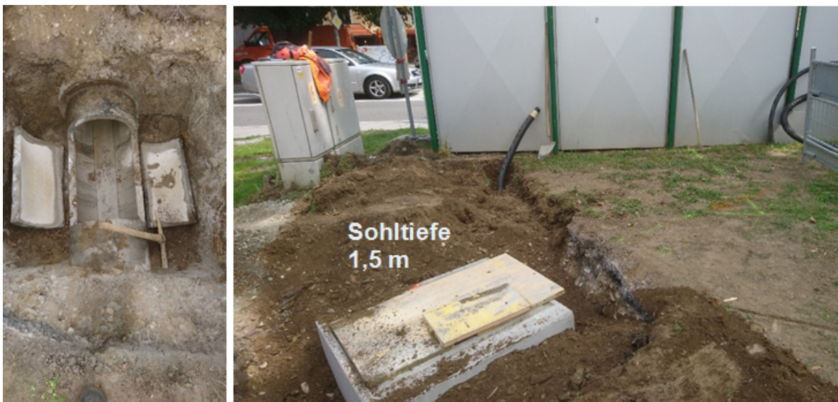
Abbildung 53: Errichtung des Einstiegsschachtes im Niederschlagswasserkanal vor der metallischen Messhütte © TU Graz
