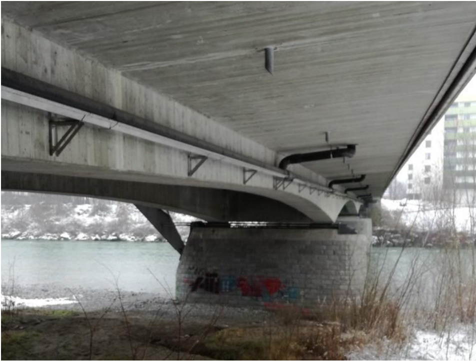
Abbildung 81: Ansicht der Brückenentwässerung der Bregenzerachbrücke an der L202 © Umweltinstitut
