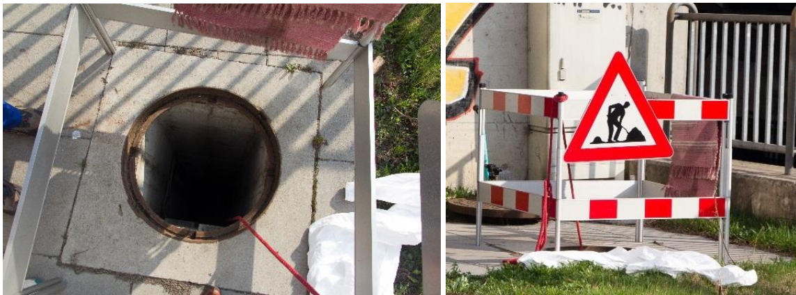
Abbildung 70: Kanalschacht zum Einstieg in die Kammer des Mischwasserüberlaufs MÜ-R05 © TU Graz
