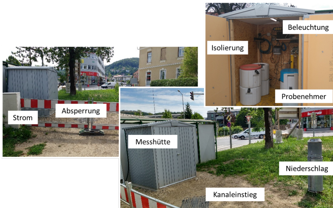
Abbildung 57: Gesamtübersicht der Messstelle Graz – Ziegelstraße © TU Graz
